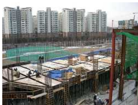
小学校教室部分現況写真(1月22日撮影)
